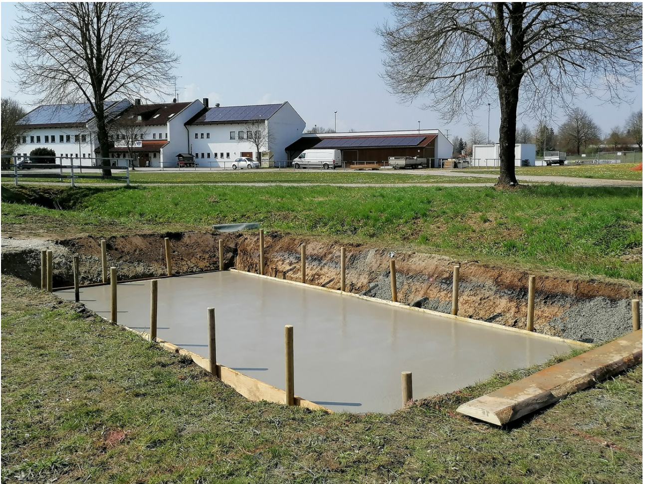
Foto: Beginn der Arbeiten für die Kneippanlage
