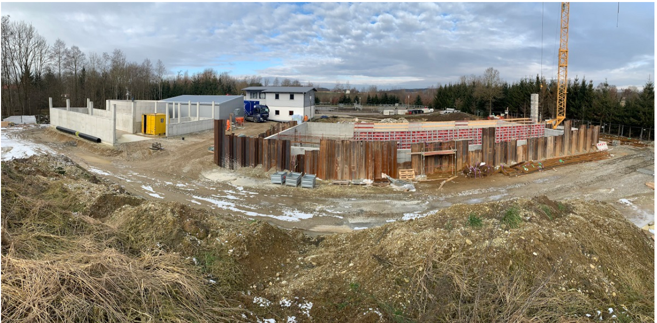
Foto: Umfassende Erweiterungsarbeiten an der Veldener Kläranlage
