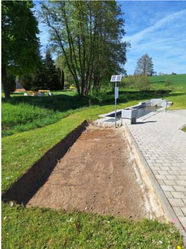
Erdarbeiten für Barfußpfad
