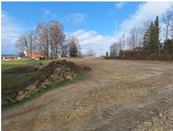
Erdarbeiten für den Dirtpark •
