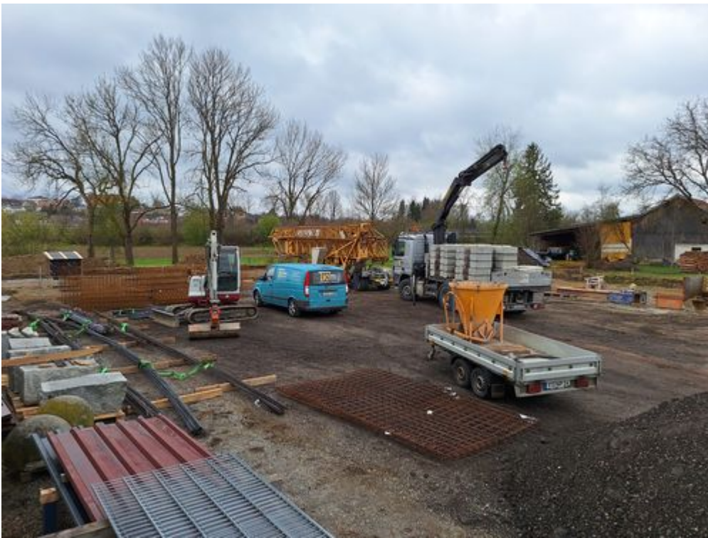
Das Baufeld für die neuen Lagerhallen
