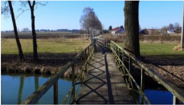
Vilsstenger vor der Sanierung, Foto: PM Ortsentwicklung
