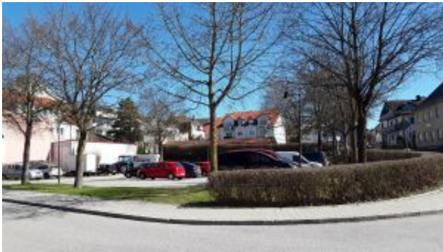
Baustelle Parkplatz in der Jahnstraße
