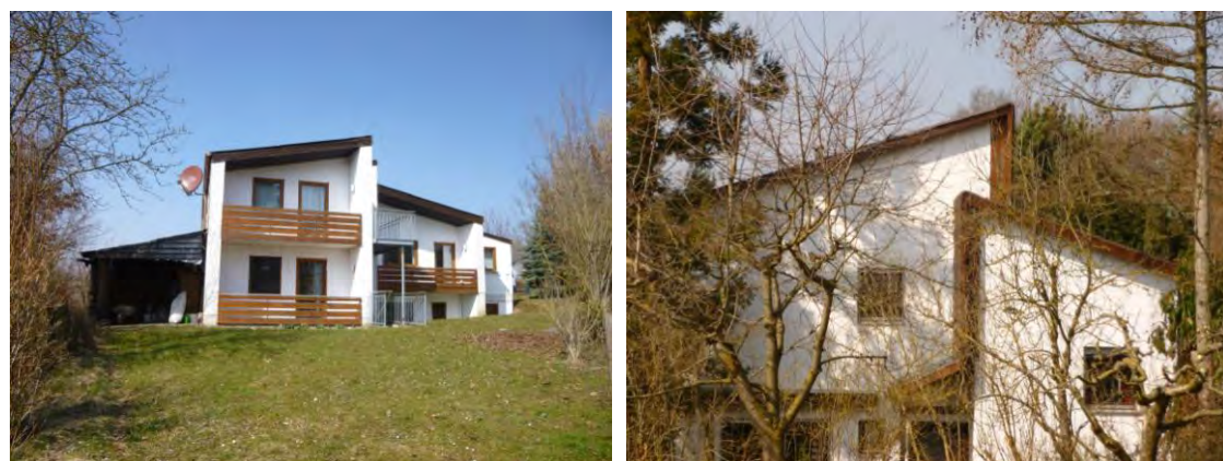
Gebäude im Baugebiet Velden-Süd Teil A
