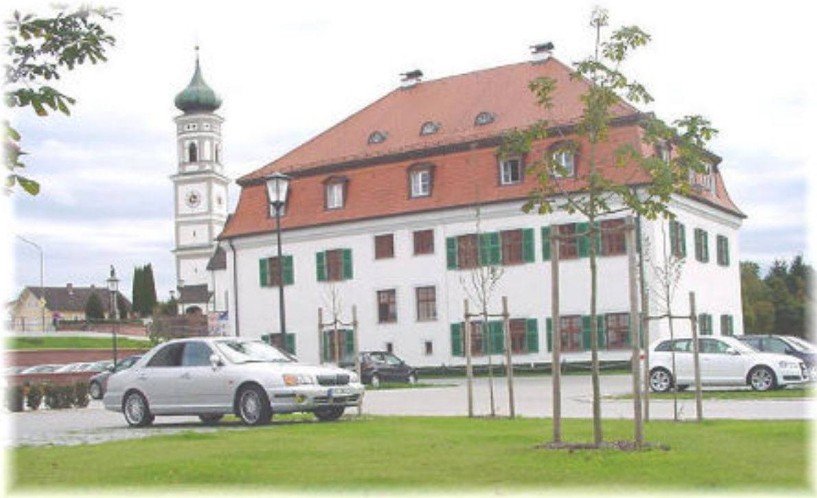
Schloss Mauern 2012 – heute Rathaus – Instandsetzung im Jahr 2009
