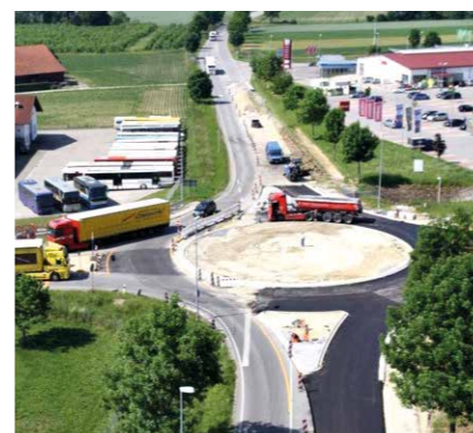
Bauarbeiten am Kreisel bei Kleinvelden im Juni 2014. Bild: Joseph Schuster
