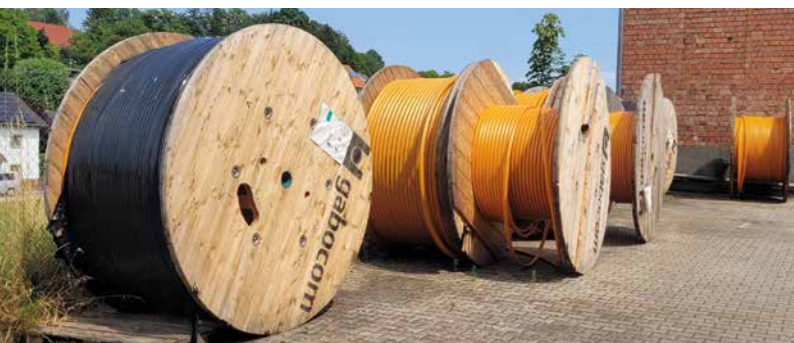
Ca. 350 Kilometer Glasfaserkabel wurden in den Jahren von 2011 bis 2023 bei Baumaßnahmen zum Breitbandausbau in Velden verlegt. Bild: St. Schütze
