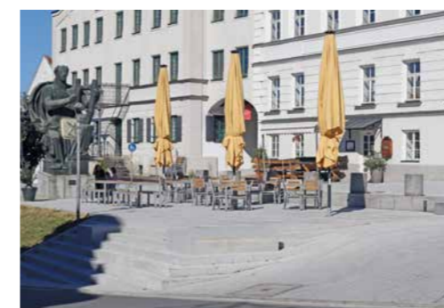
Die Sanierung des Bereichs vor dem alten Rathaus am Marktplatz und dem Vorplatz des Apolls wurde im September 2023 abgeschlossen. Bild: St. Schütze
