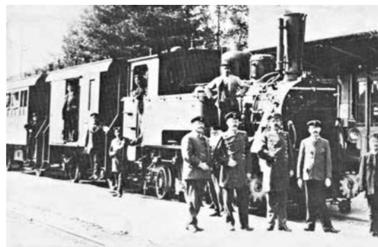
Lokalbahnzug bay D XI Nr. 2009 nach Velden im Bahnhof Dorfen, ca. 1901/02. Bild: Archiv Markt Velden
