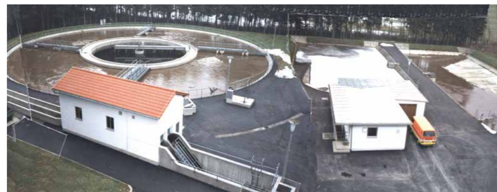
Die Kläranlage bei Biedenbach kurz nach der Inbetriebnahme 1976. Die Anlage wurde zuerst von 01.04.1976 bis 31.10.2001 von Michael Heimel und anschließend von Anton Roppert geleitet. Sie ersetzte die im Laufe der Jahre völlig unzulänglich gewordene Anlage an der Großen Vils in der Nähe der „Burgermühle“ am Mühlweg. Bild: Archiv Markt Velden
